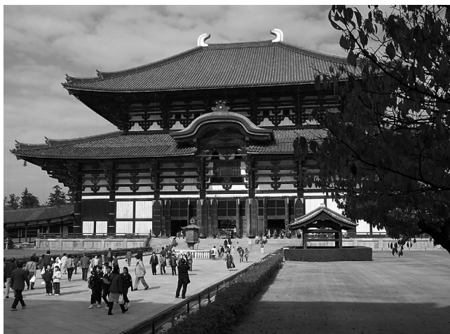
Figura 2. Templo Tōdai-ji (728) en Nara. Una vista de la majestuosidad de la fachada desde el pasillo-corredor circundante.
